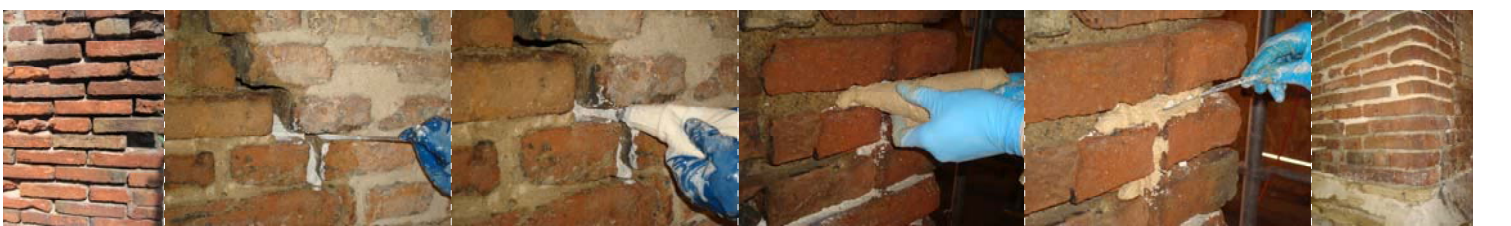
Stato di fatto prima del restauro. Da sinistra, foto generale del degrado della superficie in laterizio e degli elementi architettonici; particolare della muratura interna della Porta interessata da diffusi depositi superficiali; particolare dei depositi coerenti presenti sulla superficie muraria del basamento di un arco; capitello in arenaria interessato da depositi superficiali ed esfoliazioni; particolare di laterizi della muratura caratterizzati da consistente dilavamento della malta di allettamento; particolare di croste nere e lacune materiche presenti su un capitello in arenaria.
