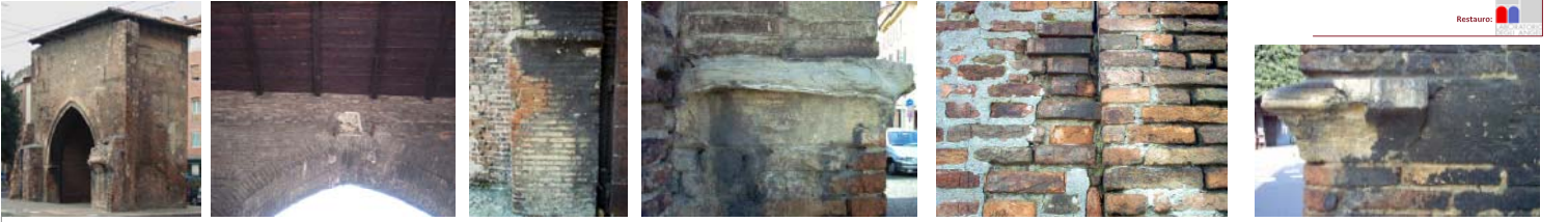
Stato di fatto prima del restauro. Da sinistra, foto generale del degrado della superficie in laterizio e degli elementi architettonici; particolare della muratura interna della Porta interessata da diffusi depositi superficiali; particolare dei depositi coerenti presenti sulla superficie muraria del basamento di un arco; capitello in arenaria interessato da depositi superficiali ed esfoliazioni; particolare di laterizi della muratura caratterizzati da consistente dilavamento della malta di allettamento; particolare di croste nere e lacune materiche presenti su un capitello in arenaria.
