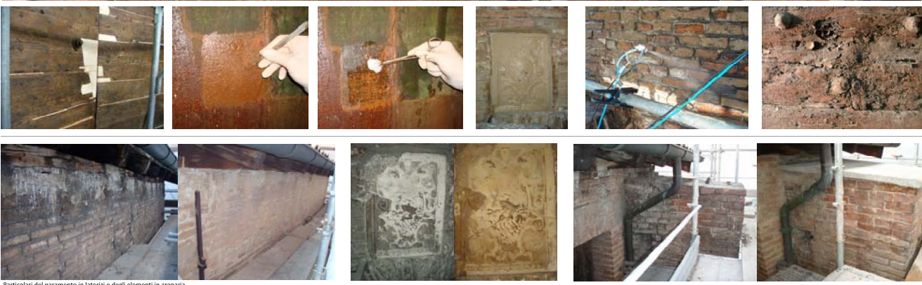
Particolari del paramento in laterizi e degli elementi in arenaria, prima e dopo il restauro.
