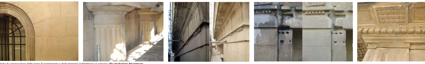
Stato di conservazione delle lastre di rivestimento e degli elementi architettonici in anneria alla conclusione del restauro
