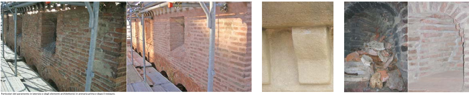
Particolari del paramento in laterizio e degli elementi architettonici in arenaria prima e dopo il restauro.
