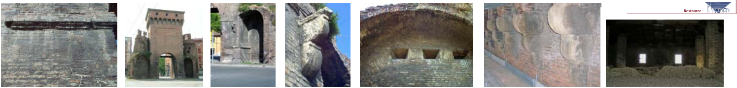
Stato di fatto del paramento in laterizio e degli elementi architettonici in arenaria prima del restauro.
