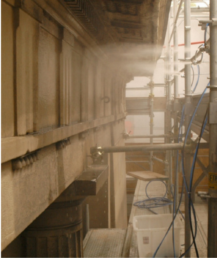
FIG. 9 – Pulitura con acqua atomizzata: immagine scattata durante l'azione dell'acqua sulla pietra.
