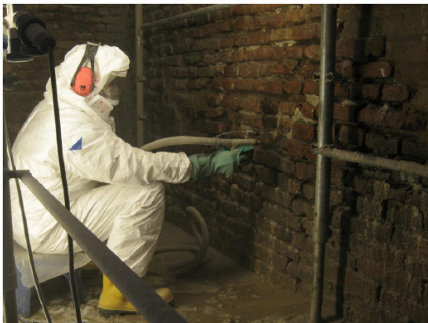
FIG. 11– Pulitura con micro sabbiatrice e acqua .
