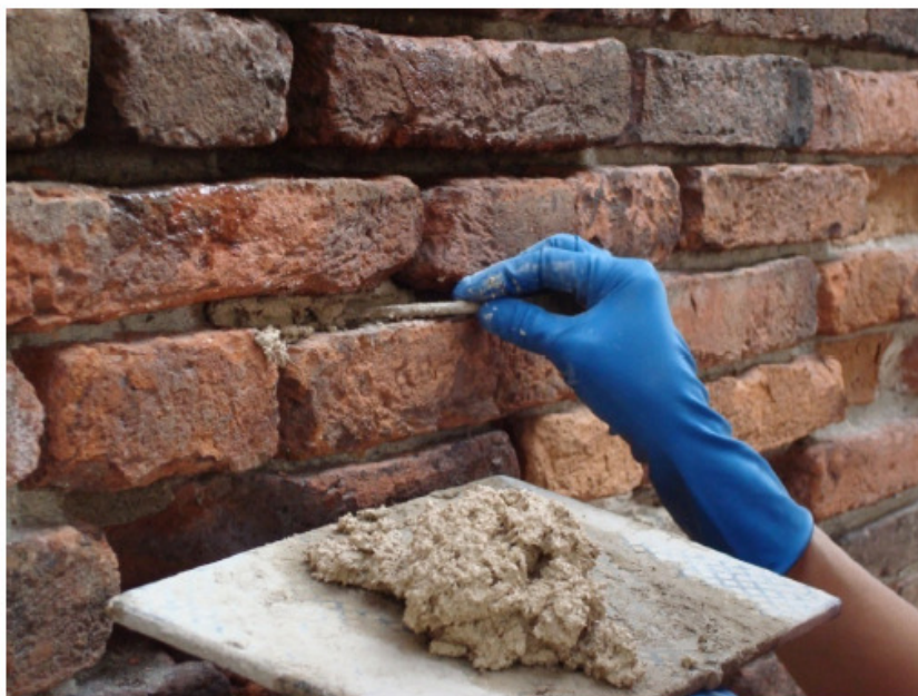
FIG. 12– Particolare durante la fase di reintegrazione delle murature con malte di allettamento .
