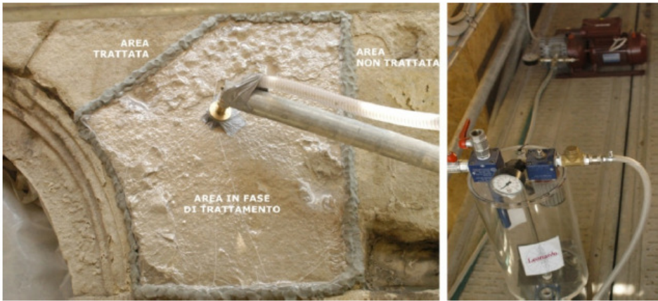
FIG. 8 – Funzionamento del consolidamento sotto vuoto dell’arenaria: nell’immagine a sinistra si vedono tre aree (trattata, in fase di trattamento, non trattata); a destra la pompa sottovuoto.
