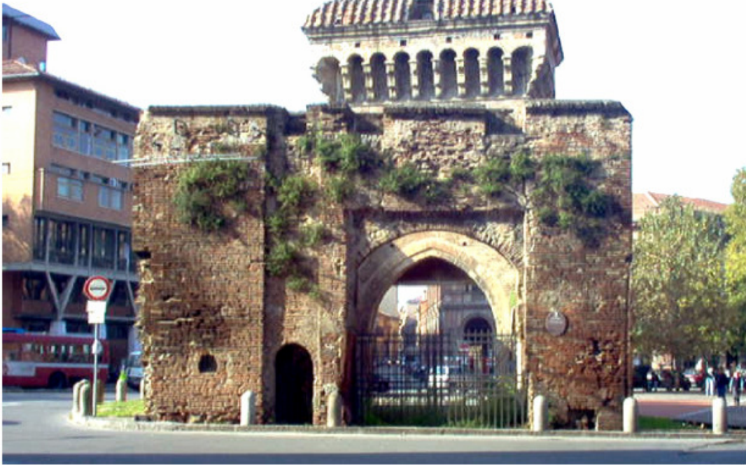
FIG. 3 – Porta San Donato, Immagine prima del restauro.
