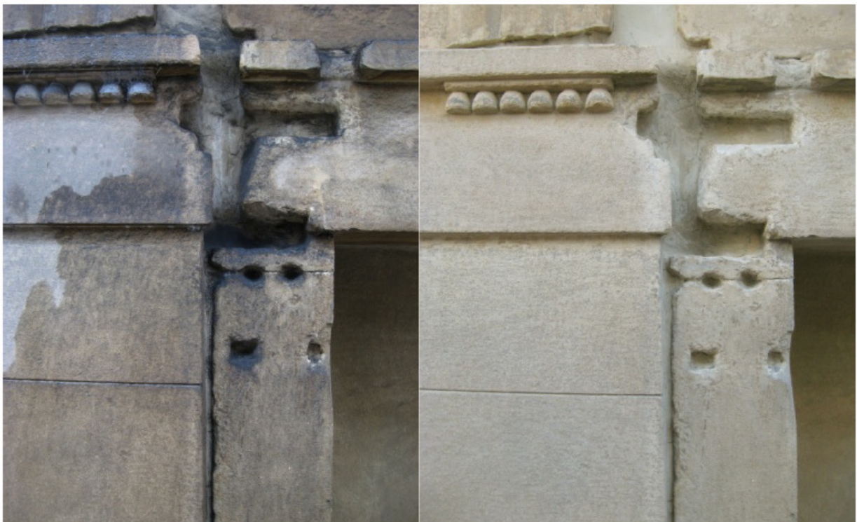
FIG. 14– Particolare di una muratura in arenaria a confronto prima e dopo il restauro .
